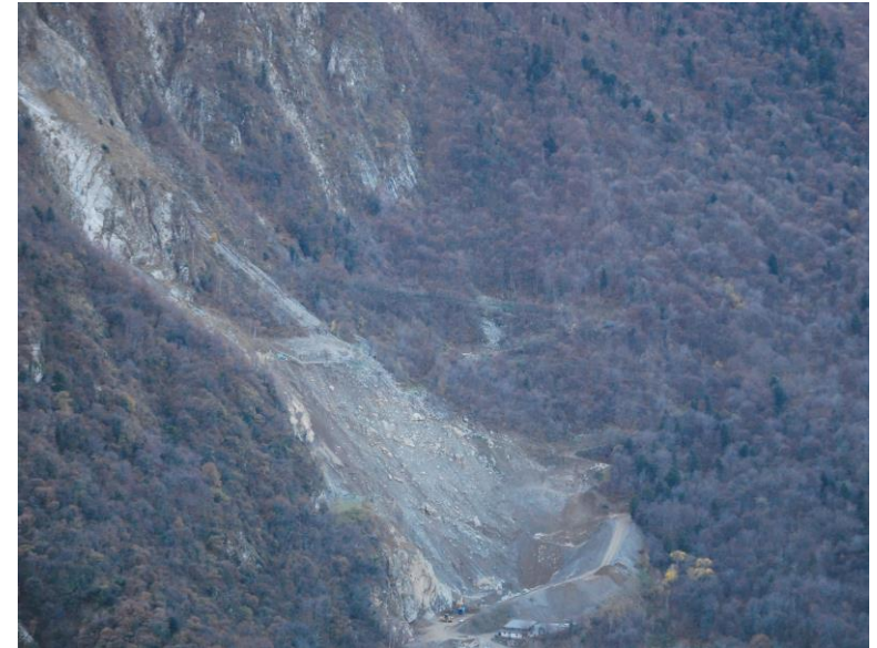
La carrière avec les éboulis, en partie haute: la plateforme d'extraction .
